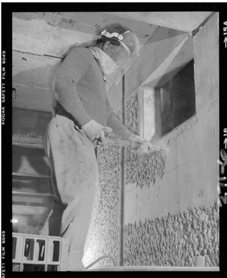
un ouvrier en train de boucharder au marteau piqueur la surface du béton. (84)
