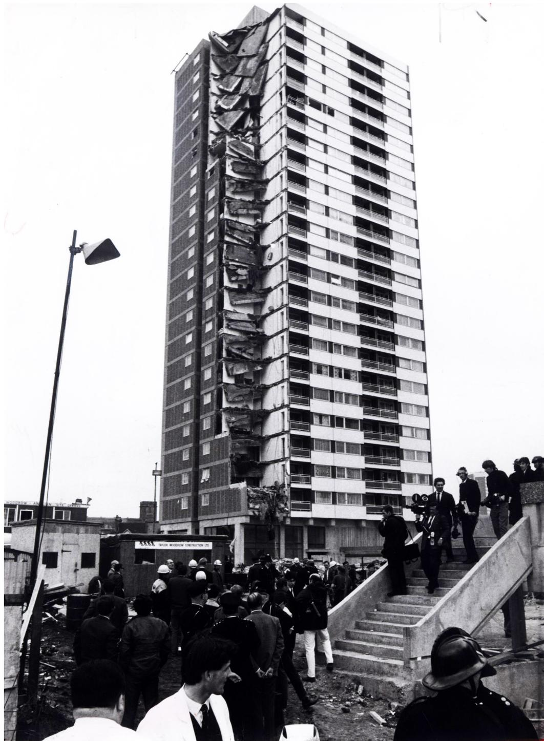
*Effrondement d'une partie de la Ronan Point Tower suite à une explosion de gaz au 22e étage.
