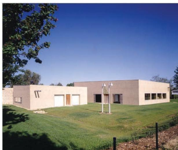
Béton de site (béton calcaire) utilisant un agrégat de composition similaire aux pierres banchées
