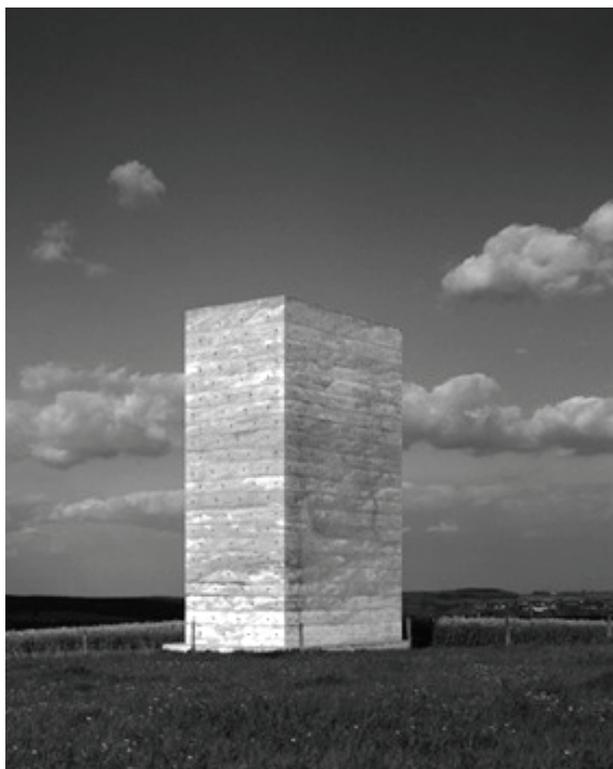
Traces de la structure de coffrage brûlée une fois le béton sec
