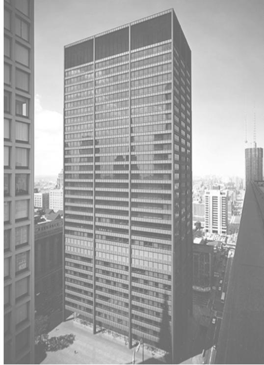
À SOM, détail de la façade du US Steel Building, New York et Chicago Civic Center. L'usage de poutres à grande portée permet l'intégration de la technique en même temps qu'une économie de points porteurs
